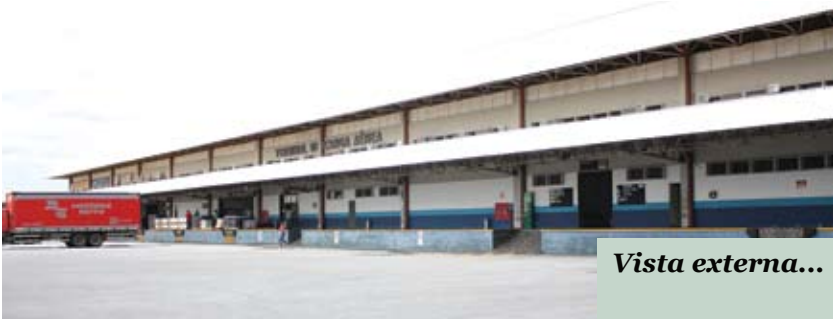
Prédio onde funciona a Inspeção, no aeroporto de Confins
